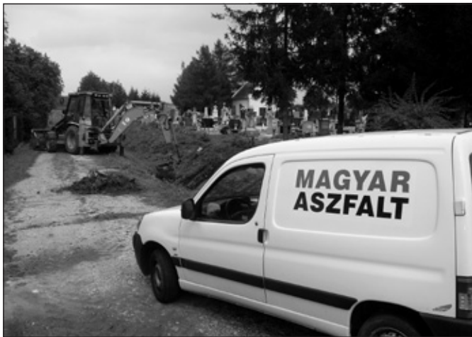
Munkában a kotrógép
