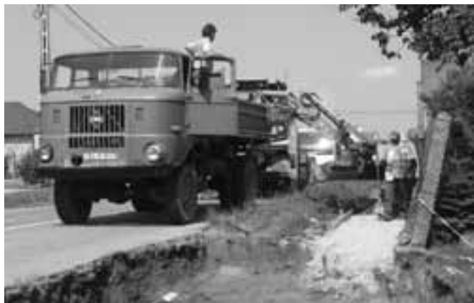
Zajlik a járdaépítés
